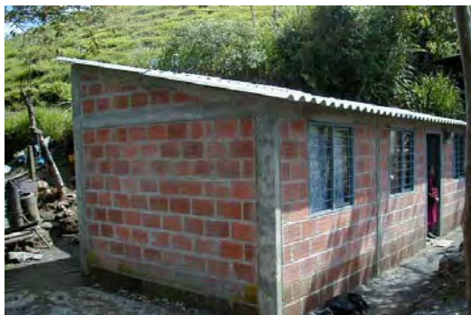
Fotografía 3-2. Edificación construida en mampostería confinada
