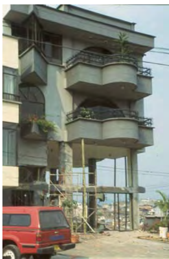
a) Piso débil con doble altura
