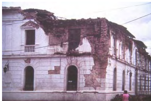
Fotografías 3-15. Daños severos en muros de tapia
