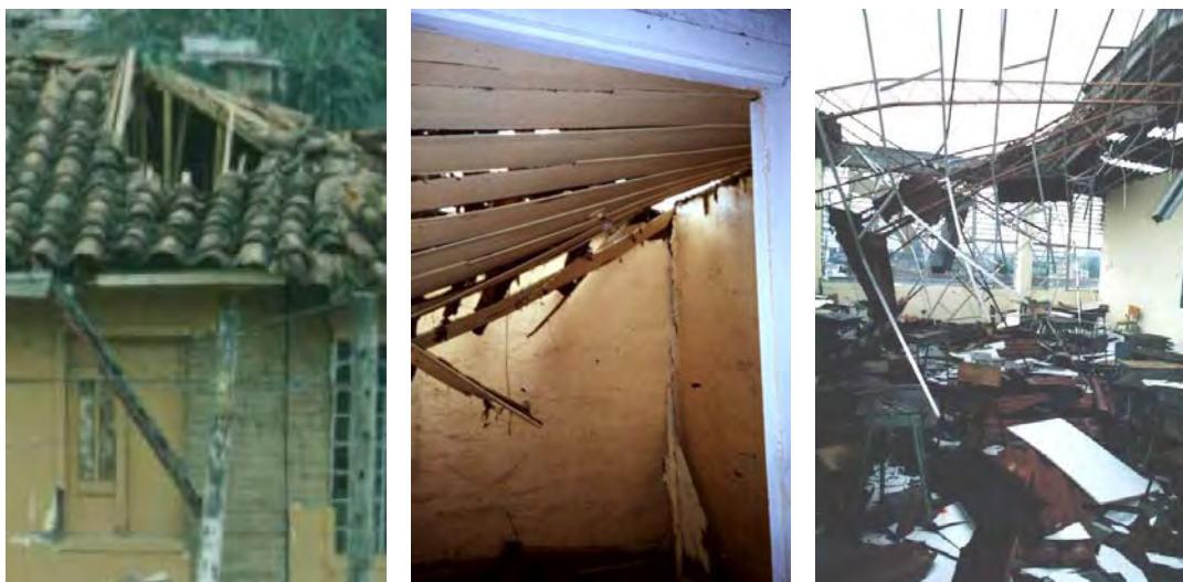
Fotografías 3-26. Daños en el sistema de cubierta
