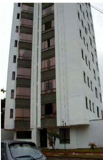
Fotografía 3-1. Edificación construida en pórticos de concreto reforzado
