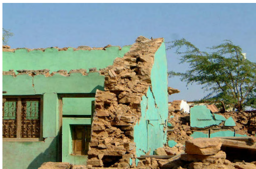
Fotografías 3-15. Daños severos en muros de tapia
