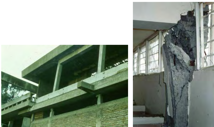
Fotografía 3-35. Falla por efecto de columna corta
