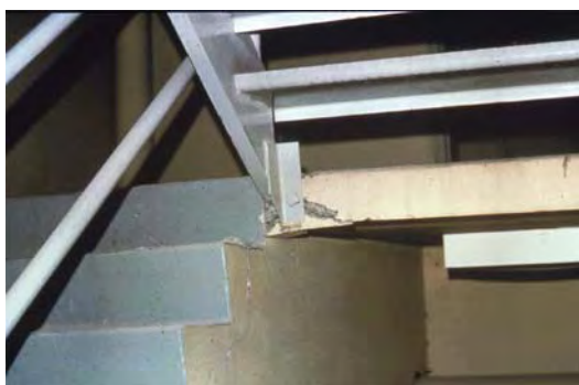
Fotografía 3-27. Daño moderado y severo en escaleras
