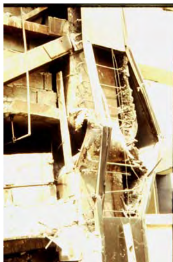
a) Pandeo de columna en pórticos arriostrados
