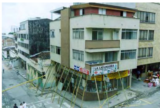
Fotografías 3-9. Inclínación de la edificación o de un entrepiso
