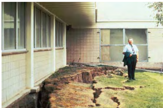
Fotografías 3-10. Fallas en el suelo de cimentación
