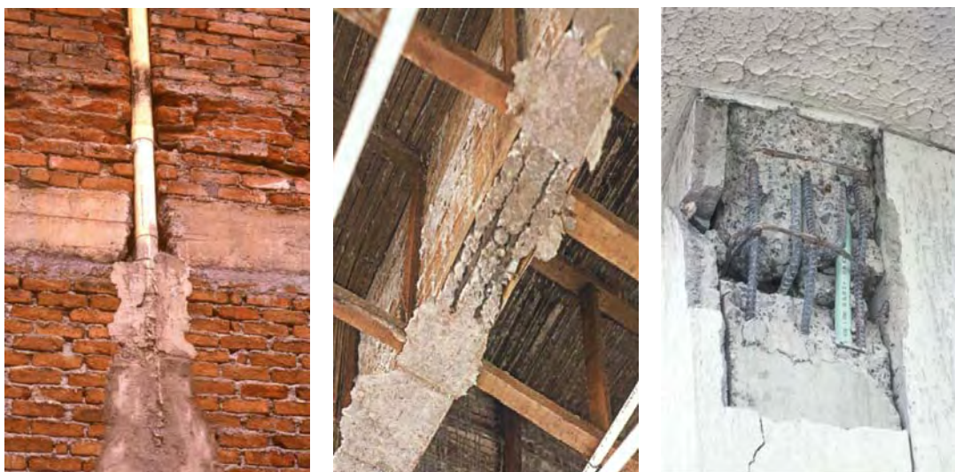
Fotografías 3-33. Ejemplos de mala calidad en la construcción
