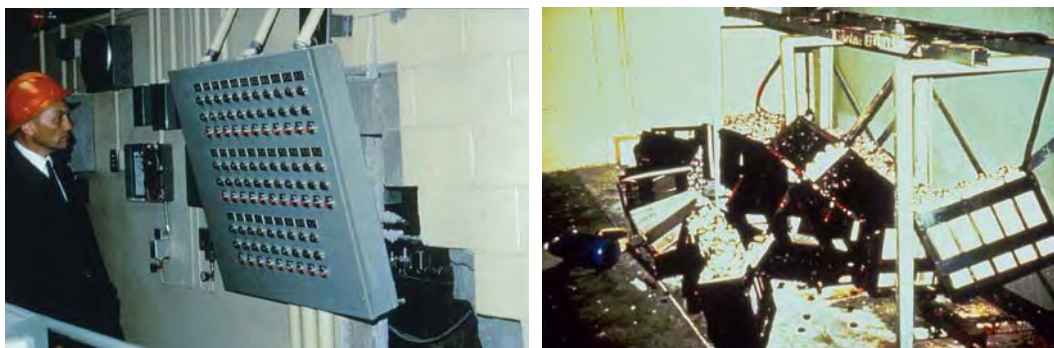
Fotografía 3-30. Daños en instalaciones y subestaciones eléctricas
