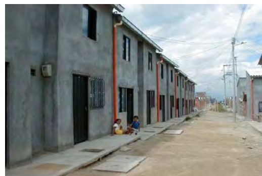
Fotografía 3-5. Edificación construida en tapia (izq.) y en bahareque encementado (der.)
