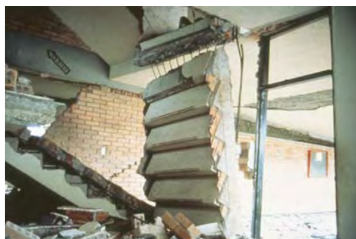
Fotografía 3-27. Daño moderado y severo en escaleras
