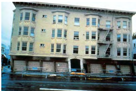
Fotografías 3-9. Inclínación de la edificación o de un entrepiso
