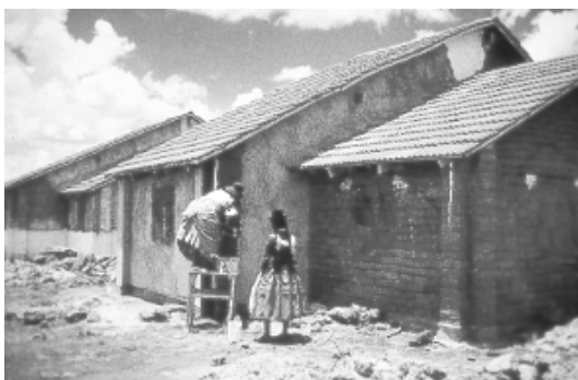
Fotografía 3-5. Edificación construida en tapia (izq.) y en bahareque encementado (der.)
