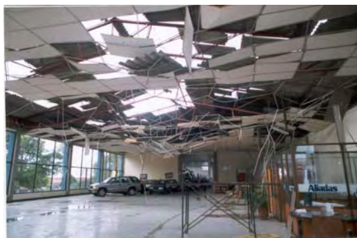
Fotografías 3-25. Daños en cielos rasos y luminarias
